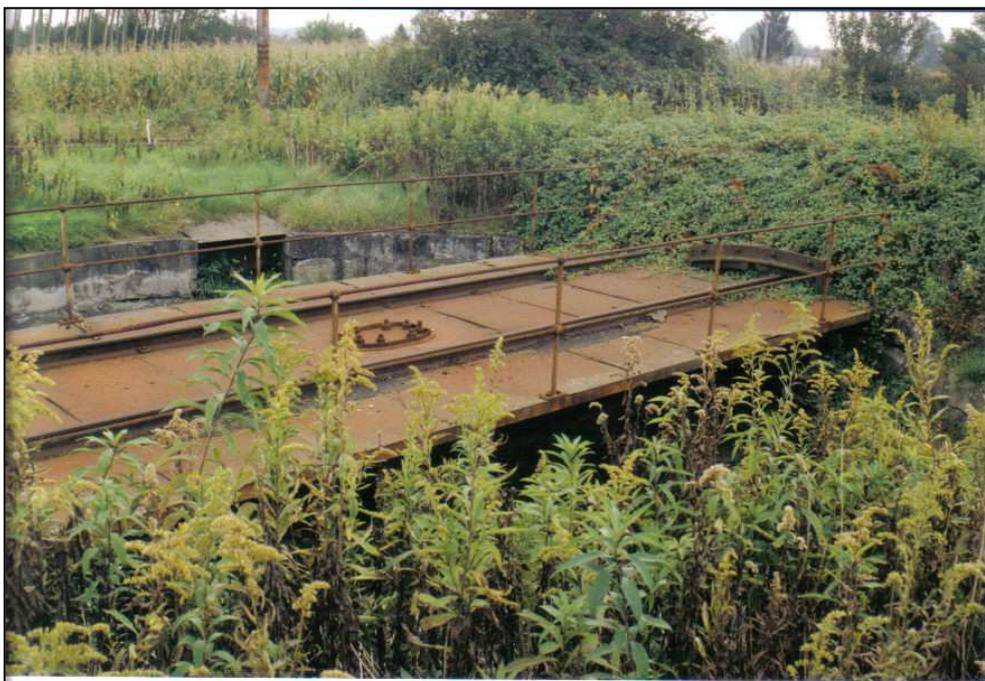
**Figura 7 – Stazione di Airasca, vecchia piattaforma giratrice**
